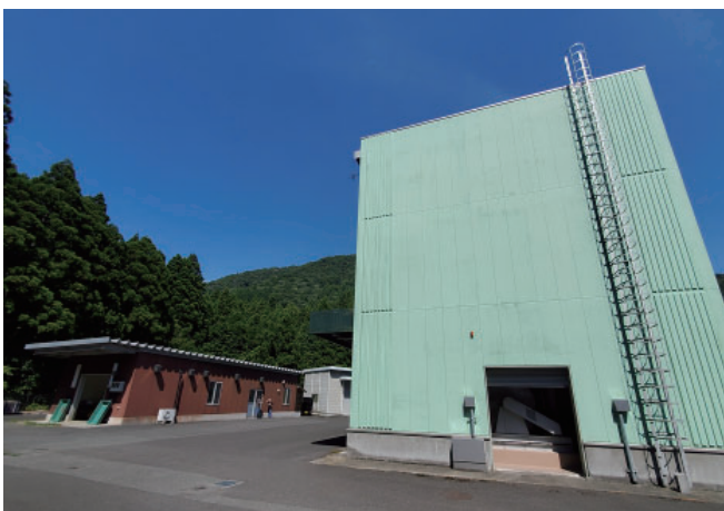
施設全体外観。右側が焼却施設、左の茶色の建物が加工施設
